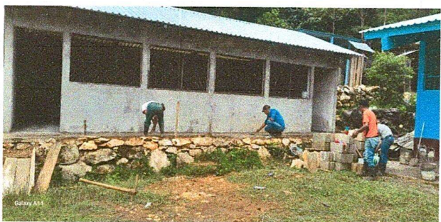
Foto 5: Colocaciones de piso de la cocina
