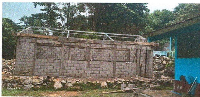
Foto 3: Instalaciones de costaneras de la cocina
