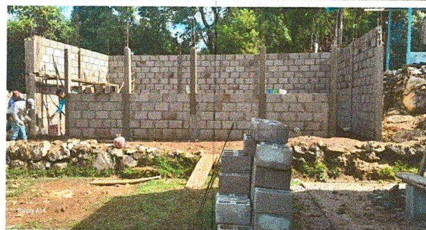
Foto 2: Construcciones de las ventanas
