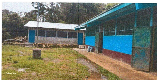
Foto 6: Instalaciones de puertas de la cocina
